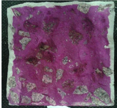
Figura 14 - Amostra de corpo de prova carbonatada após aspersão de fenolftaleína.
